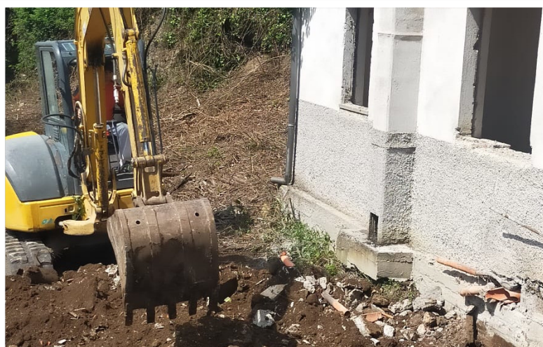
Demolizioni, disboscamento e riorganizzazione esterna alla foresteria
