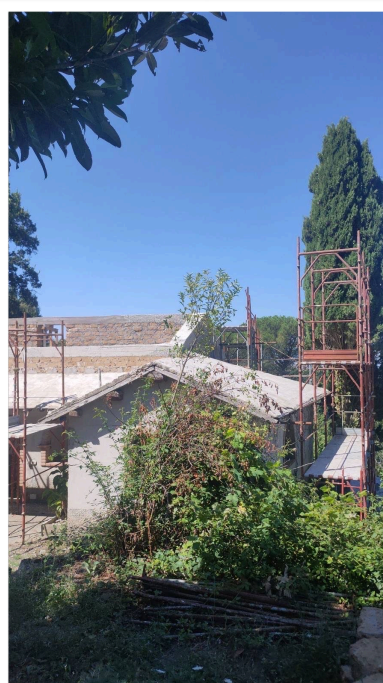
Rifacimento dei tetti
