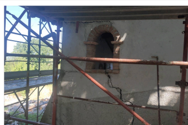
Ristrutturazione della foresteria
